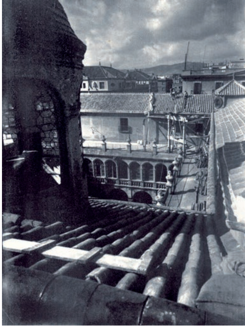
FOTOGRAFIA 50. Obres de restauració de la Casa de Convalescència als primers anys trenta del segle XX. (Fons Gabriel Casas i Galobardes. ANC.)
